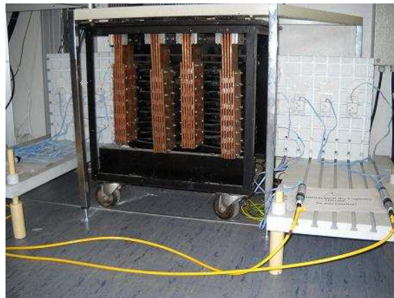
Figure V-7. Dispositif du banc d'essai avec les différents éléments
