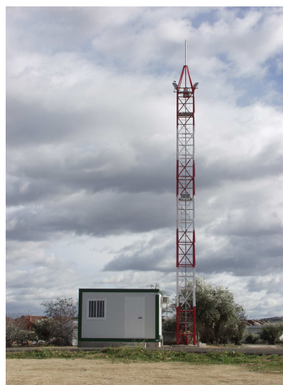
Figura 2. Torre y caseta de control
