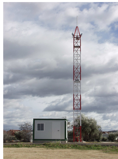
Figura 2. Torre y caseta de control
