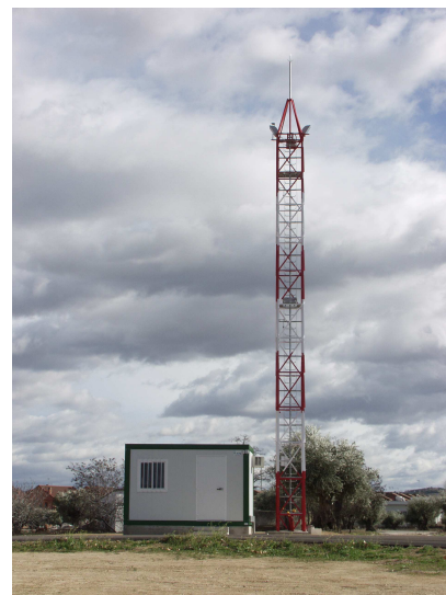
Figura 2. Torre y caseta de control
