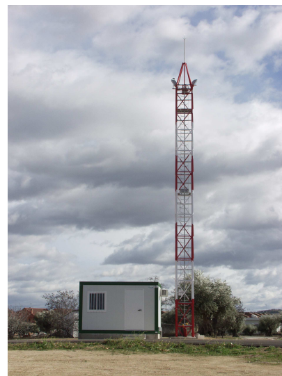
Figura 2. Torre y caseta de control
