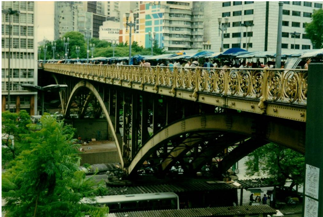
Figure 1 Santa Efigênia Bridge, São Paulo, Brazil (ARQUIGRAFIA, 1997).
