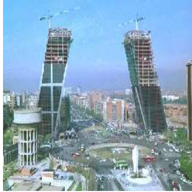
(a) Torres Kio, Madrid.
