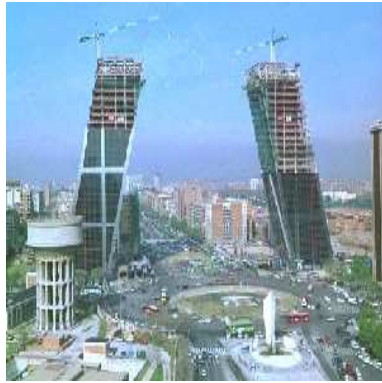
(a) Torres Kio, Madrid.
